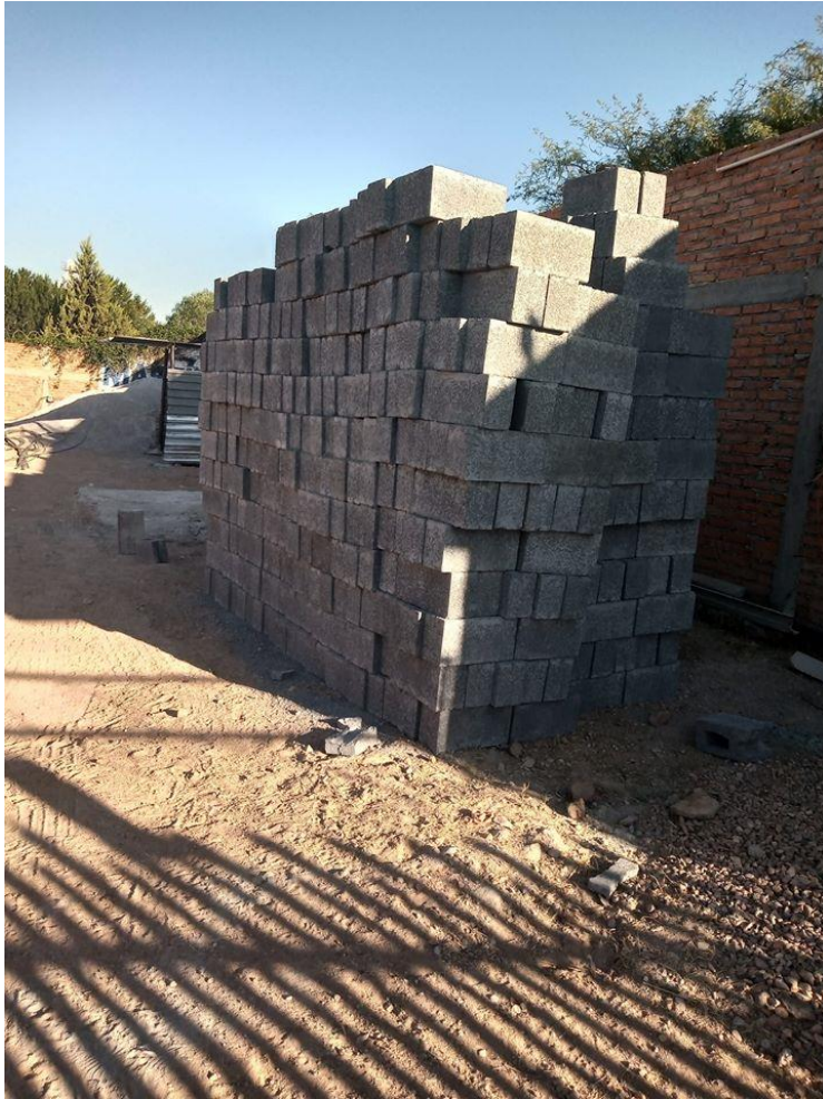
Proceso de elaboración de los 1000 bloques - Figura 9
