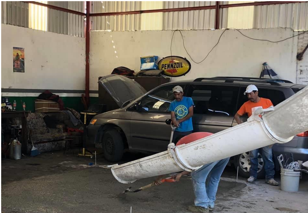
Colado de cemento en taller mecánico - Figura 3
