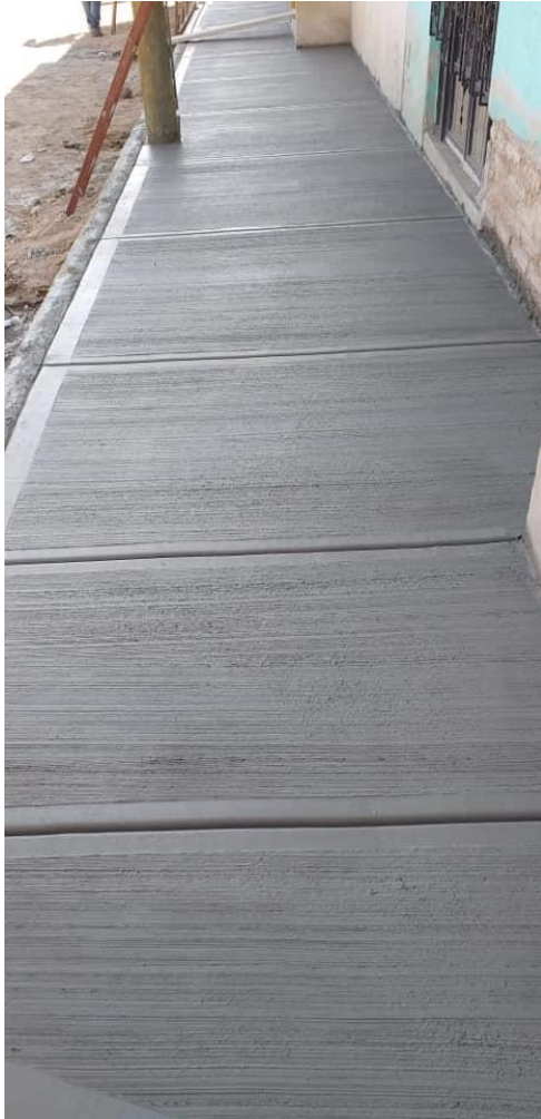
Prueba con agua directa de pipa – trabajo de colado - Figura 13
