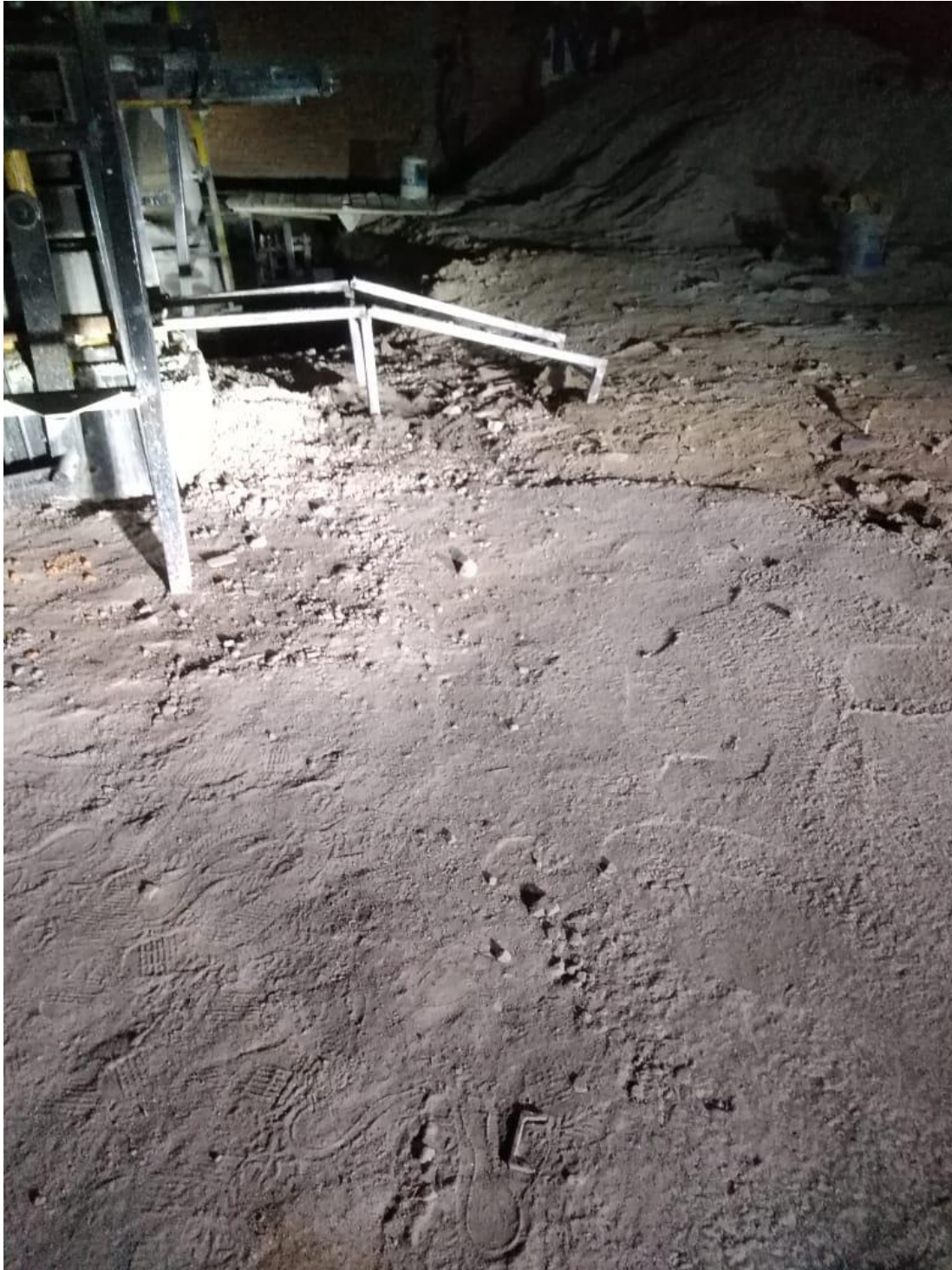
Proceso de elaboración de los 1000 bloques - Figura 8
