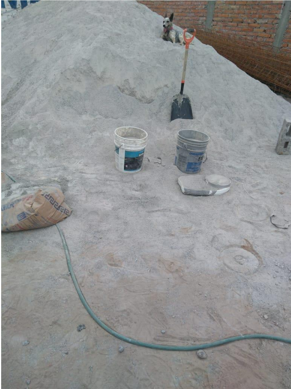
Proceso de elaboración de los 1000 bloques - Figura 7
