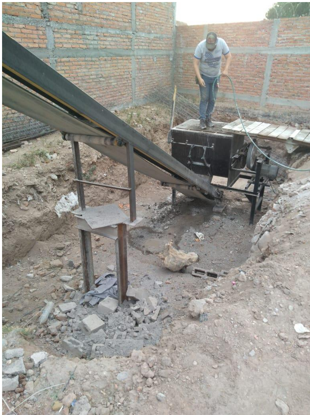
Proceso de elaboración de los 1000 bloques - Figura 6
