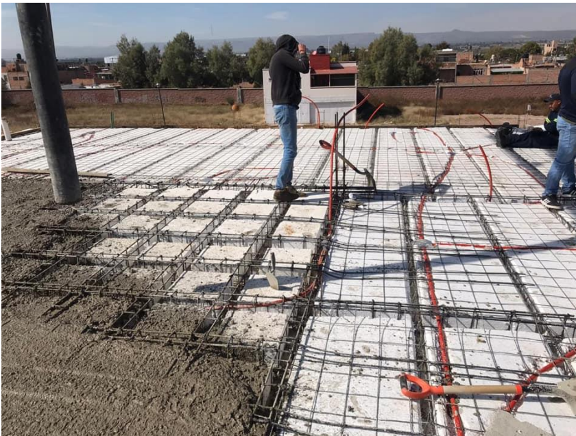
Colocación de cemento sobre techos - Figura 2
